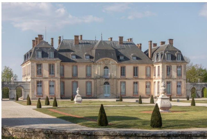
01. Vue d'ensemble terrasse sud
