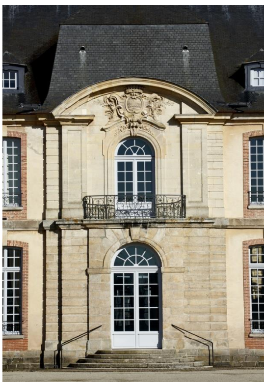
03. Façade sur cour, travée centrale
