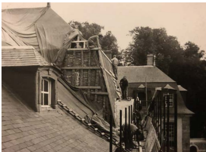
Photographie des travaux de réfection des toitures du château dans les années 60.
